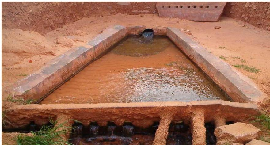
Le drain, lorsqu'il se trouve en dehors de la nappe aquifère, a un rôle qui se limite au transport de l'eau. Dans la partie (active), la galerie pénètre sous la surface d'eau de la nappe et la draine tandis que la partie aval (non active) achemine l'eau seulement grâce à une légère pente vers les terrains à irriguer. C'est seulement la galerie qui pénètre dans la nappe, qui est active.
